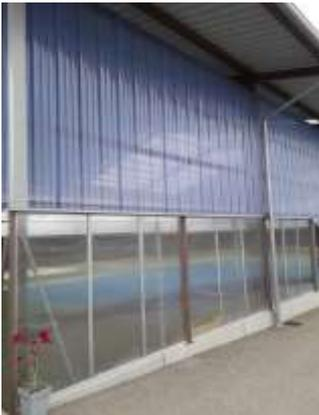
Les travaux de fermeture de la halle tennis ont débuté par la mise en place de plaques de polycarbonate sur les murs de soutènement.
